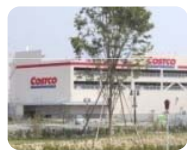
14 コストコホールセール 入間倉庫店(底地)
